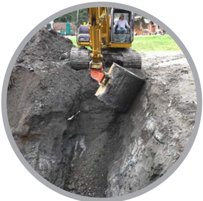
Sicurezza degli scavi
