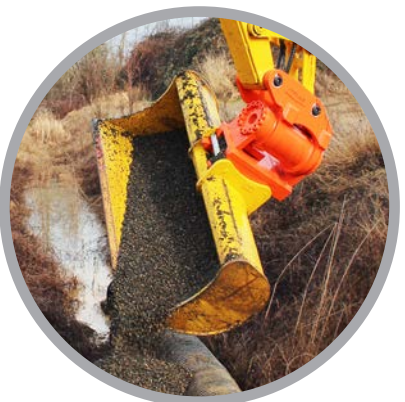
Misurazione del materiale di riempimento
