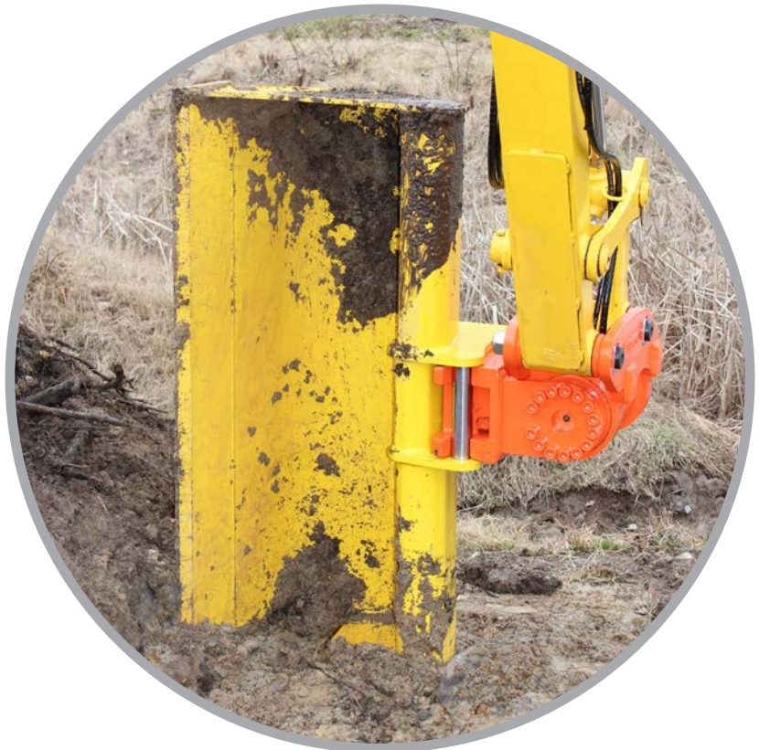
Nettoyage de fossé
