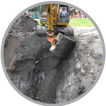
Sécurisation de tranchée
